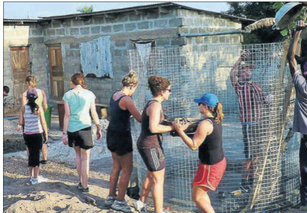
Bild eines Wassertank-Baus in Ghana. Im März 2013 zeigte hier die Hochschulgruppe Global Brigades der Universität Bayreuth in einem Dorf vollen Einsatz.
